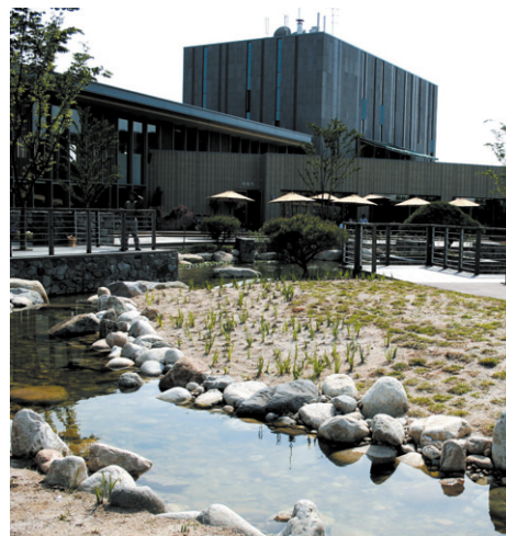
덕평랜드 210RT지열 냉, 난방시설
