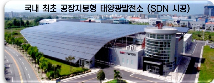
SDN(주) 공장지붕형 태양광발전소 - 1MW(2009.08)
