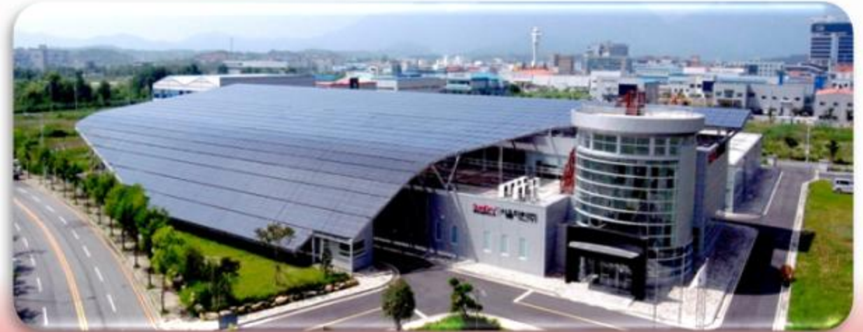
국내 최초 공장지붕형 태양광발전소 (서울마린시공)
